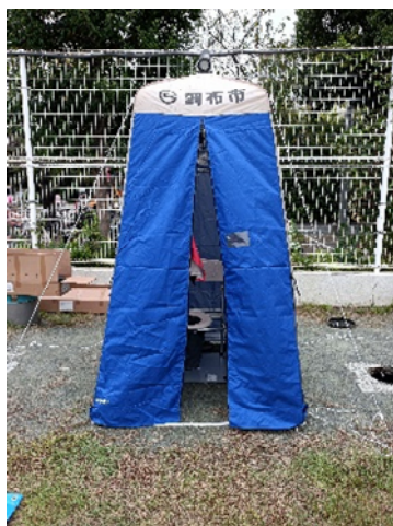
マンホールトイレ設営完成
