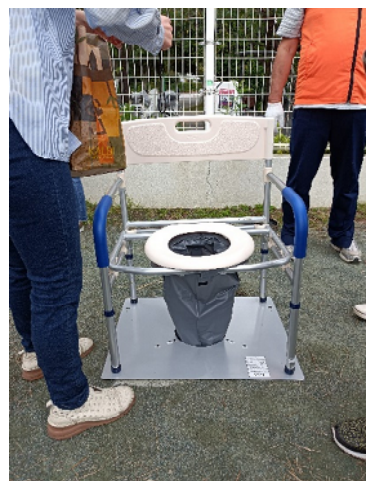
マンホールトイレ組み立て中
