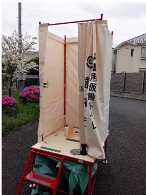
洋式トイレ設営
