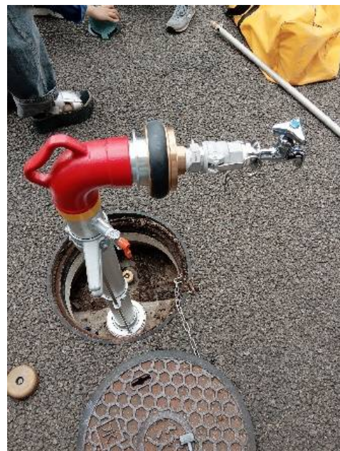
応急給水栓設置
